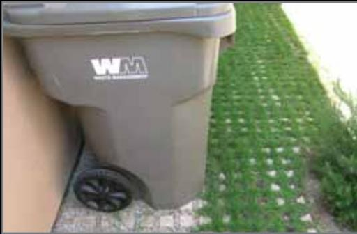
AGGREGATE INFILL / TURF
